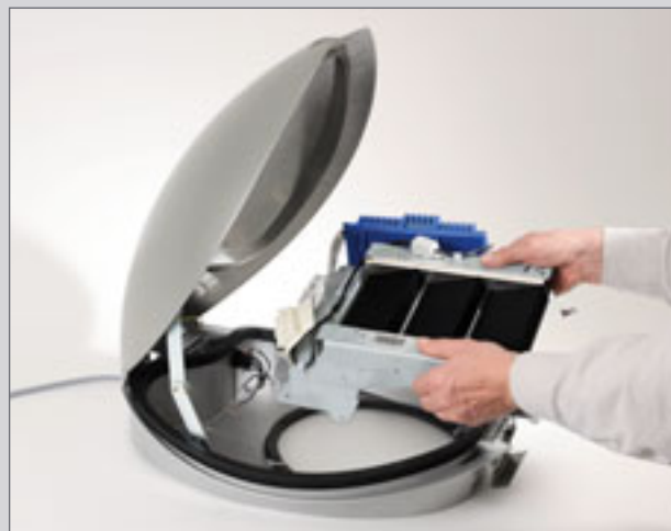
5. Geräteträger entnehmen und durch Geräteträger mit neuer LED-Generation ersetzen.
