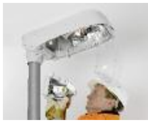
Alten Geräteträger entfernen
