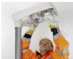
Uneffiziente, alte Quecksilberdampf Lampe entfernen
