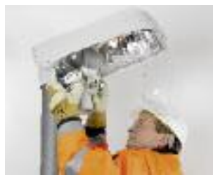
Neuen Geräteträger einsetzen
