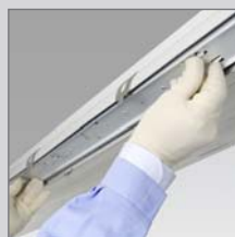
3. Geräteträger öffnen
